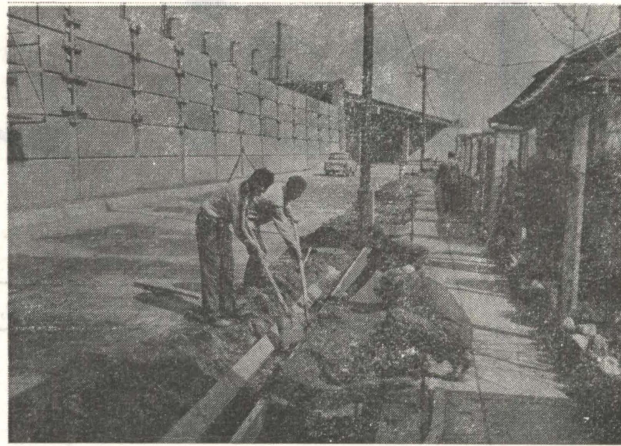
Készül a csapadékvíz elvezetésére a beton folyóka.
