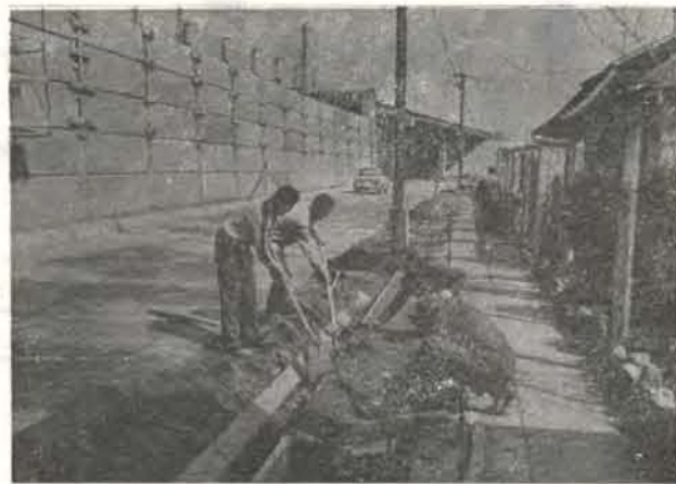
Készül a csapadékvíz elvezetésére a beton folyóka.
