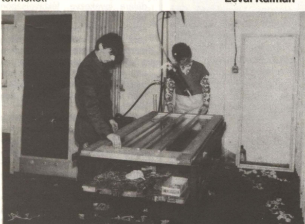
A „Halas” típusú ajtó szerelése
